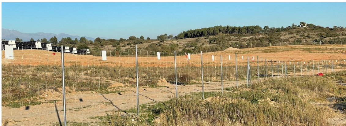
Figura 13. Ejemplos de señalización del vallado perimetral mediante placas reflectantes.
